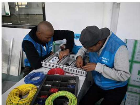
2018年12月3日，南非学生在苏州科茵斯智能科技有限公司做自动化设备电控盘配线。
